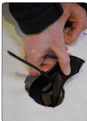
Pres underdelen sammen, og før den ind på bagsiden af undertaget.
