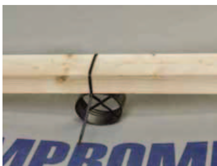
Stripsen strammes så undertagsstrammeren er fastholdt til lægten.
