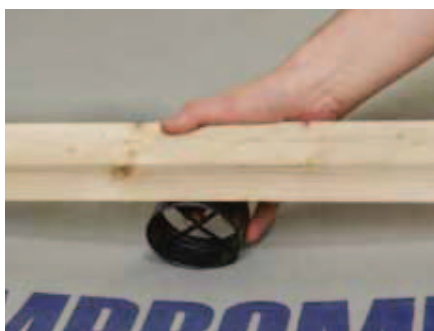
Undertagsstrammerne føres ned mellem undertag og lægte.
